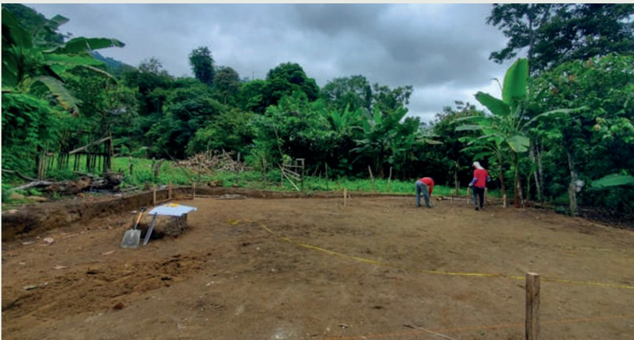
Trazado de ejes y componentes de cimentación.
