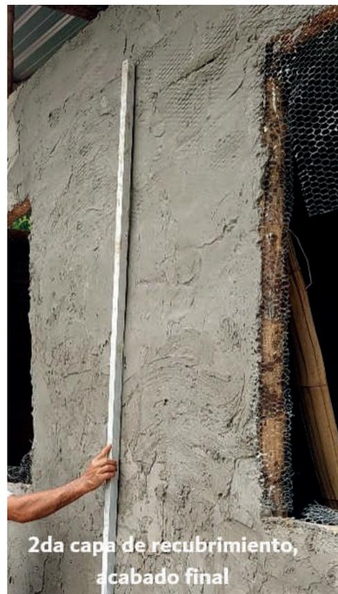
Recubrimiento con mortero de arena/cemento.
