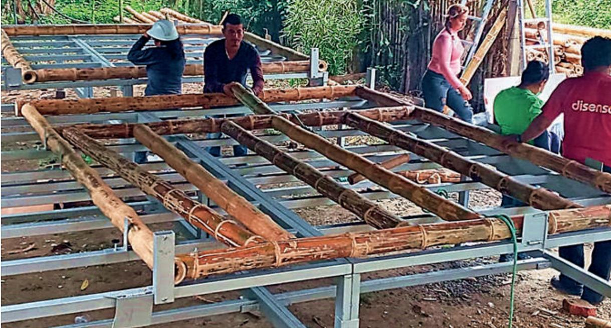
Armado de pórticos en el Sistema de molde ajustable.
