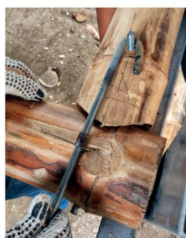
4. Perno de anclaje perpendicular
