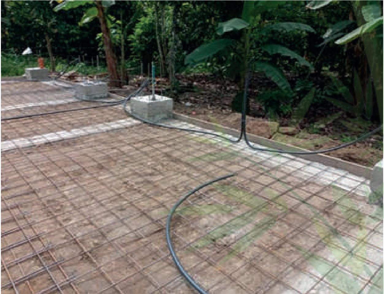
Malla electrosoldada de contrapiso de Sistema estructural porticado.
