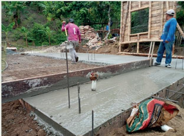
Fundición de Losa de cimentación.
