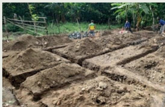
Trazado de perímetros y excavación de la cimentación.
