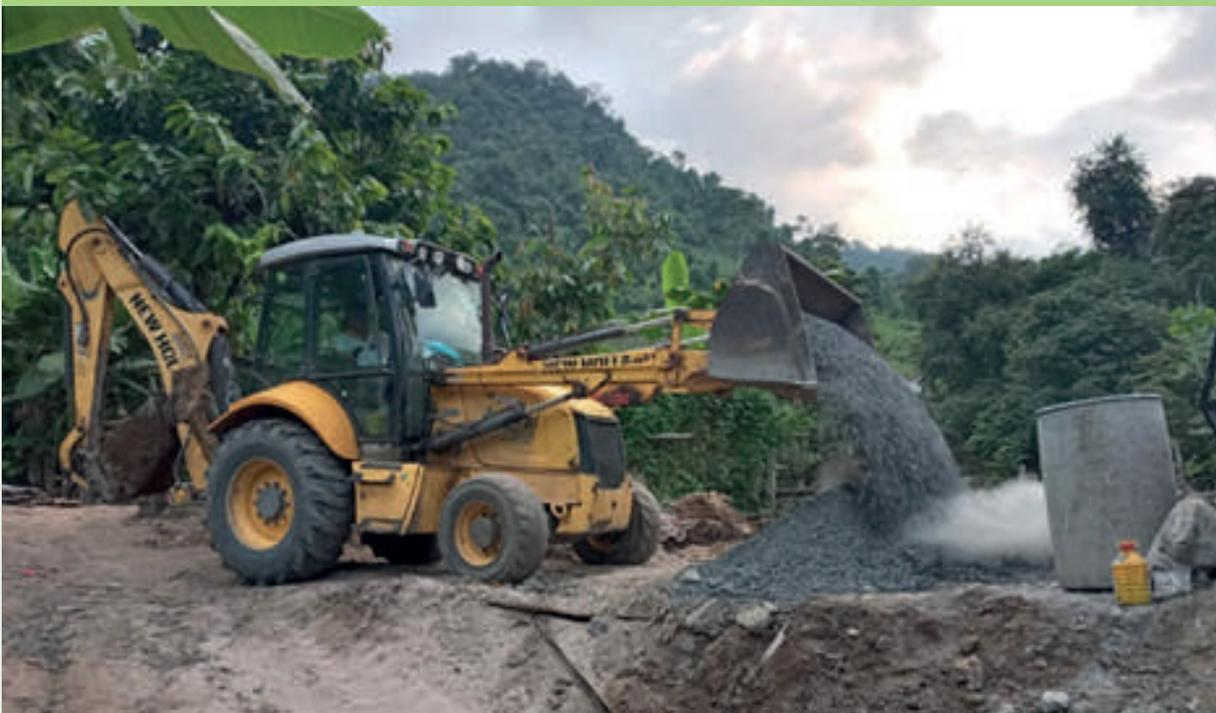
Retroexcavadora utilizada para limpieza y nivelación del terreno.
