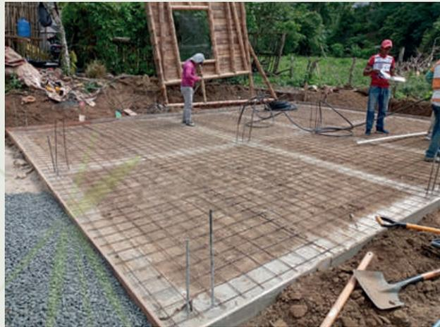
Malla electrosoldada previo fundición de losa de cimentación.
